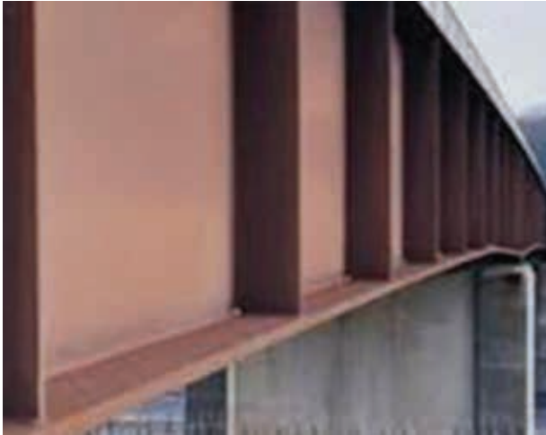
Figura 2.- Puente carretero en acero autopatinable.
