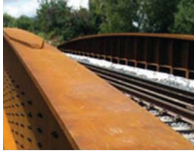
Figura 3.- Puente de ferrocarril en acero autopatinable.
