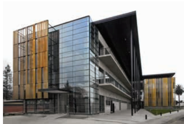
Figura 8.- Edificio fábrica Nestlé, Graneros, Chile (Barra, 2017).
