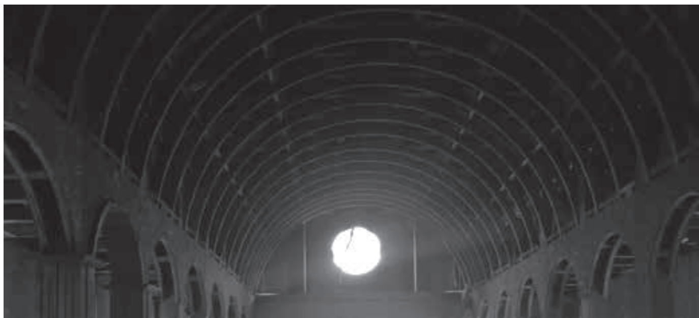
Estructura de la boveda. Detalle.
