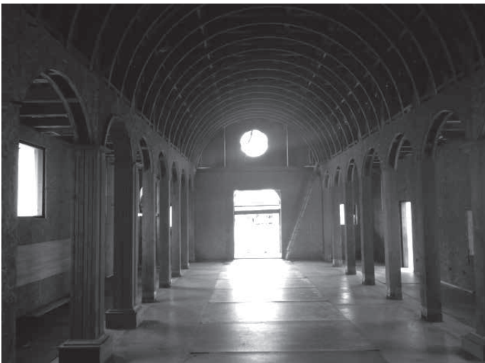
Figura 8. Vista interior. Fase revestimiento. Fuente propia.
