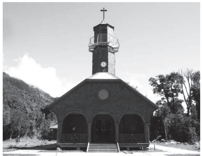
Figura 3. Fachada Vodudahue, vista acceso principal. Fuente propia.
