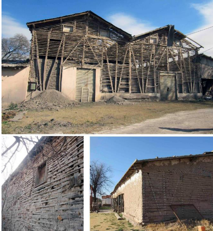
Figura 4. Estructura principal de madera (columnas y vigas) en muros de las bodegas Figure 4. Main wooden structure (columns and beams) in walls of the wineries
