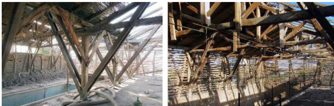
Figura 6. Elementos estructurales de madera para sostener la cubierta
