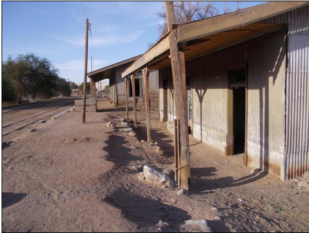
Foto 6: Vista del sector Estación Quillagua
