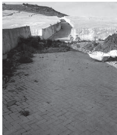
Fig. 4: Fragmento de pavimentación de Corso Umberto
