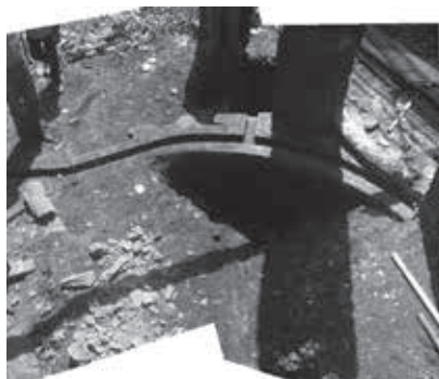
Fig. 3: Trazas. Pavimento en edificio C
