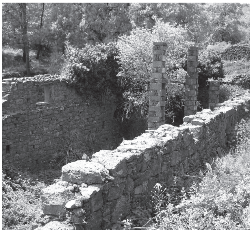
Fig. 2: Restos del edificio B. Bodegas
