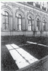
Fachada a intervenir
