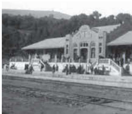
Estación de la Ciudad Puerto de San Antonio. Arqto. Eduardo Vigneaux 1936 (demolida).
