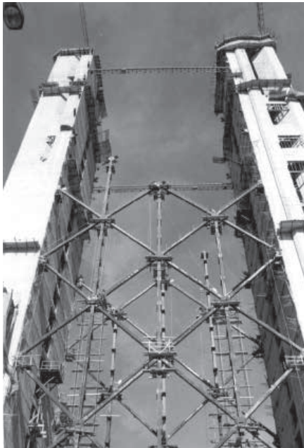
Figura 3. Edificio Telefónica. Fuente: René Lagos.
