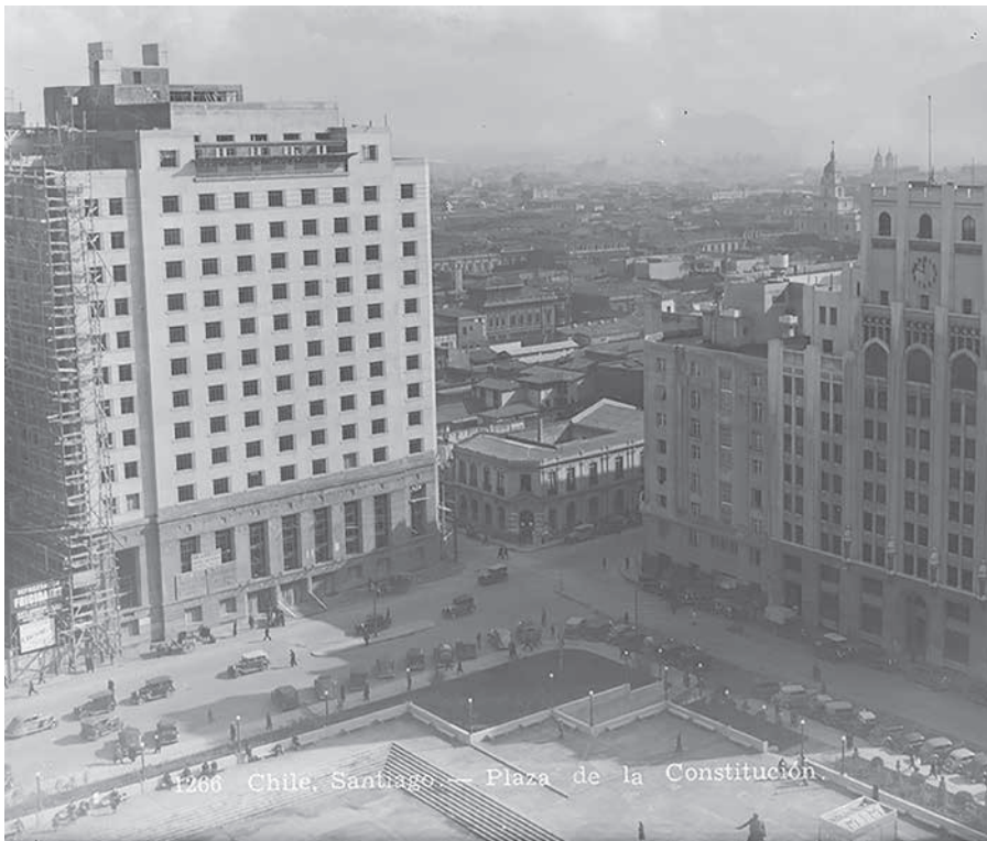
Figura 2. Vista aérea Barrio Cívico en construcción. A la izquierda ex Hotel Carrera en construcción, a la derecha edificio ex Diario La Nación (1936-52c) © Enrique Mora Farraz. Fuente: Cultura Digital Universidad Diego Portales.
