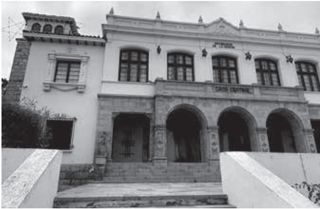
Vista fachada norte.
