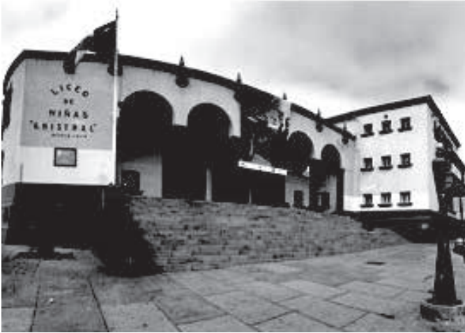
Vista fachada norte.
