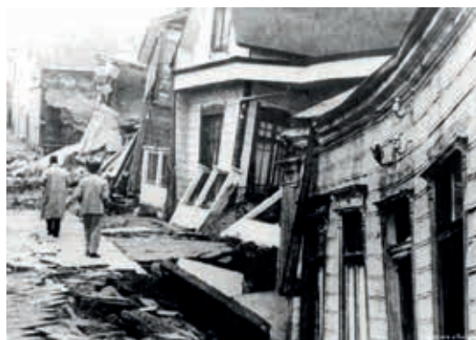
Figura 2: Terremoto Valdivia – 1960. Fuente: dw.com
