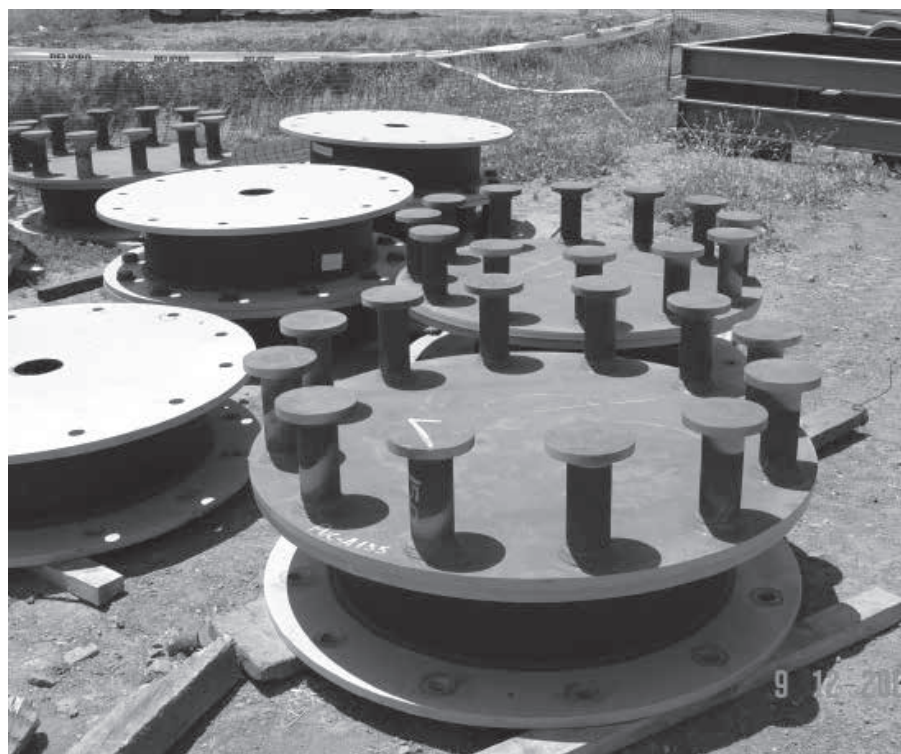
Figura 1. Hospital Militar. Aislador Basal. Fuente: Daniel Stagno.
