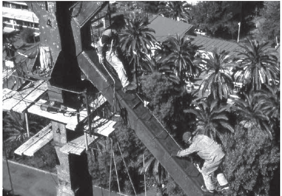
Figura 4. Edificio Telefónica. Fuente: René Lagos.
