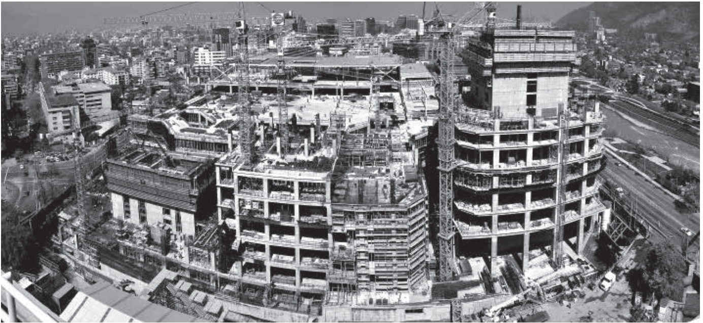
Figuras 6. Edificios Costanera Center. En construcción. Fuente: René Lagos.
