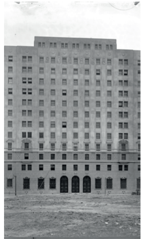
Figura 3. Fachada principal del Ministerio de Hacienda recién concluido. Fuente: Ministerio de Obras Públicas, Dirección de Arquitectura, Archivo fotográfico.
