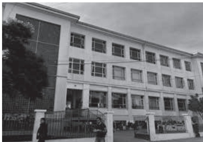
Vista fachada norte.
