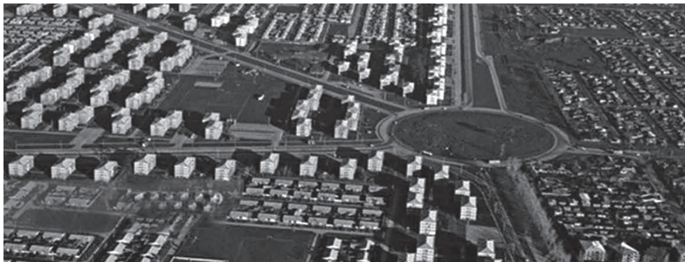
Detalle vista aérea del sector de rotonda Grecia.
