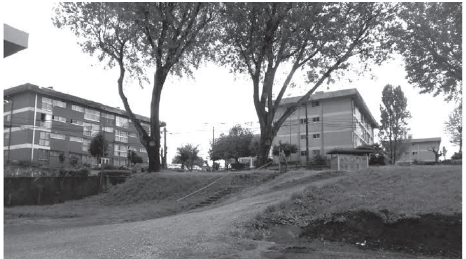
Figura 5. Conjunto de Colectivos 1010 / 1020 en sector de Laguna Redonda (1970) en Concepción, en que los bloques varían su disposición reconociendo la topografía. Fuente: M. Costas. 2016.
