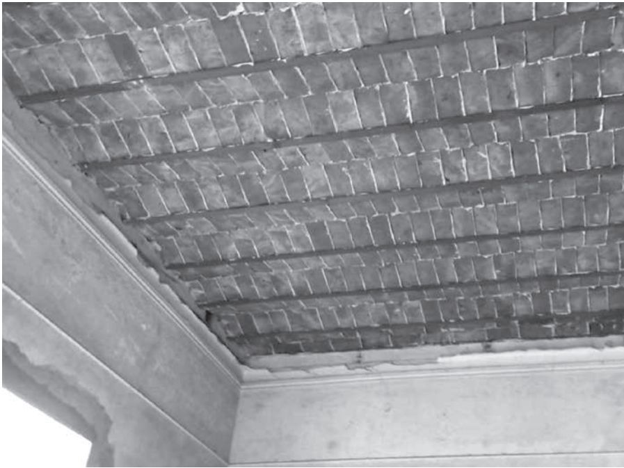
Figura 1. Bovedilla de perfiles y mampostería. Fuente propia.
