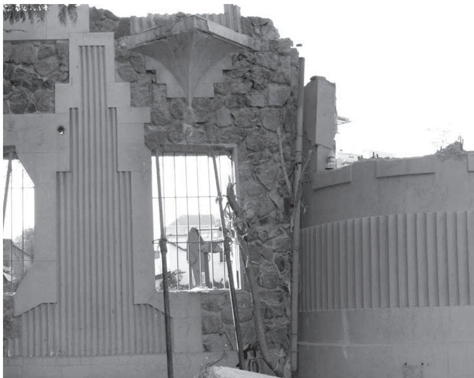
Demolición. Fuente propia.
