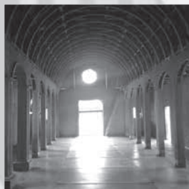
Proyecto Iglesia Vodudahue. Maderas locales, estructura desmontable y sin clavos.
