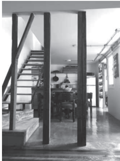
Figura 7. Estructura roble del muro de quincha. Fuente propia.
