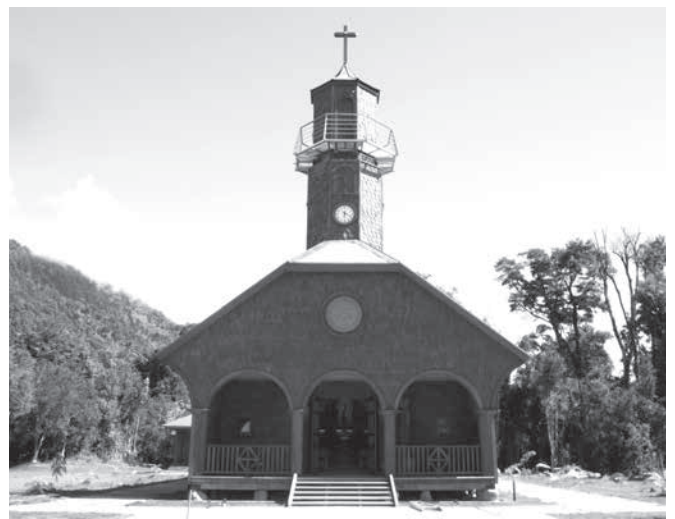
Figura 3. Fachada Vodudahue, vista acceso principal. Fuente propia.
