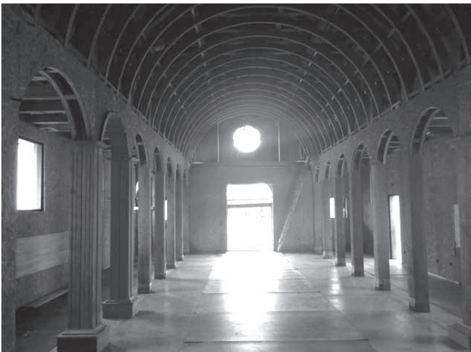
Figura 8. Vista interior. Fase revestimiento. Fuente propia.
