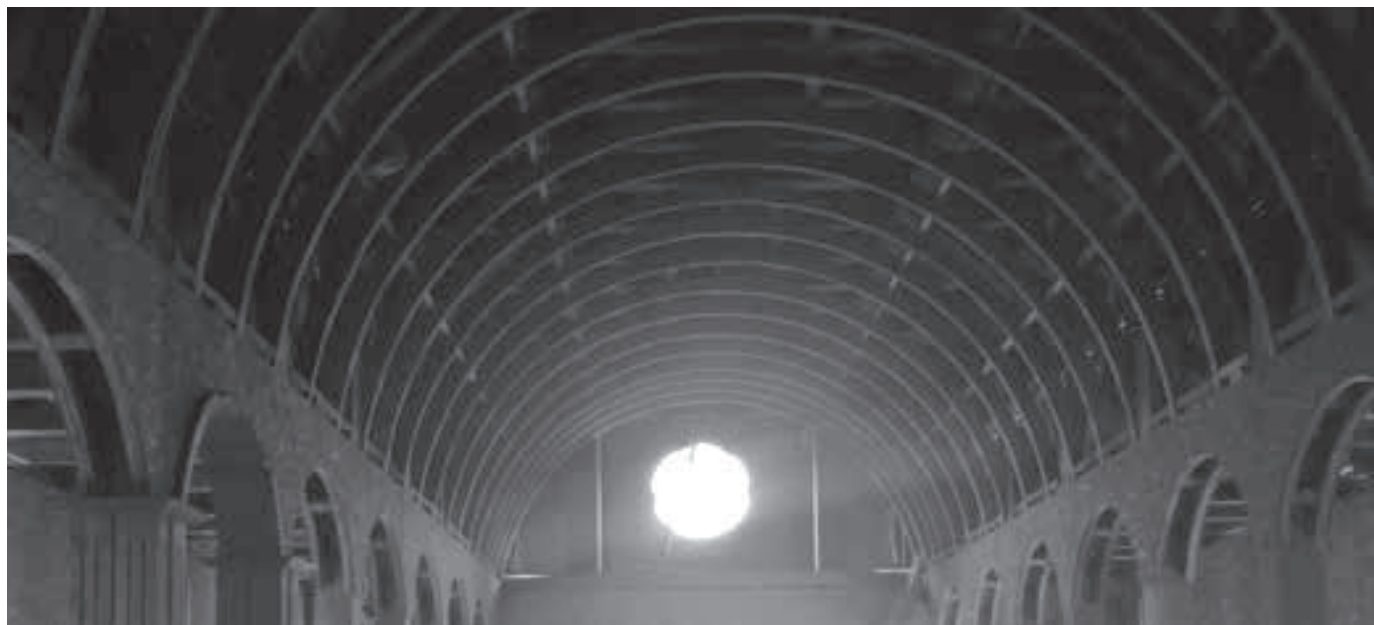
Estructura de la bóveda. Detalle.
