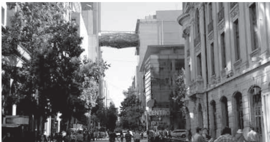
Figura 5b. El puente y su volumetría actúa como punto de atención para el caminante, su forma en contraste con la arquitectura del centro histórico lo convierte en un hito de la calle Bandera. Vista desde nivel de calle. Imagen intervenida. Fuente: Basilio Robledo, 2014.
