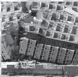
Edificaciones y napas freáticas superficiales
