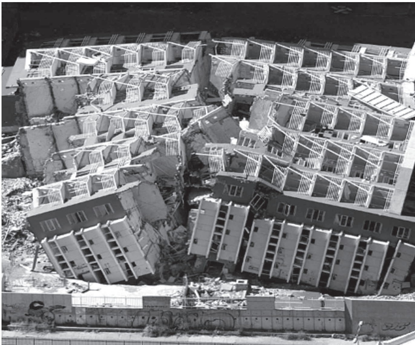
Figura 7. Vista aérea del edificio Alto Río (EMOL).
