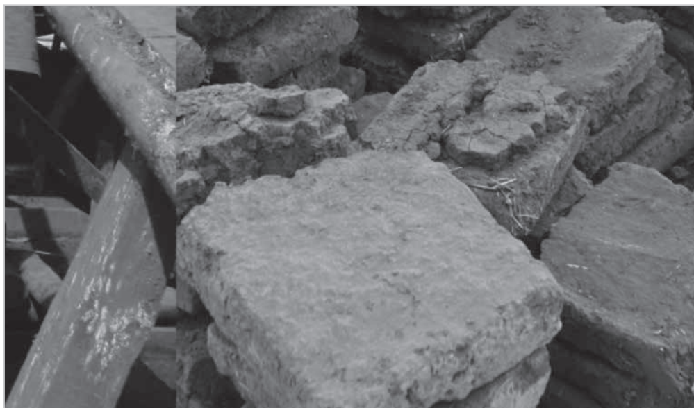
Detalle Figura 4. Desmantelamiento y clasificación de materiales.
