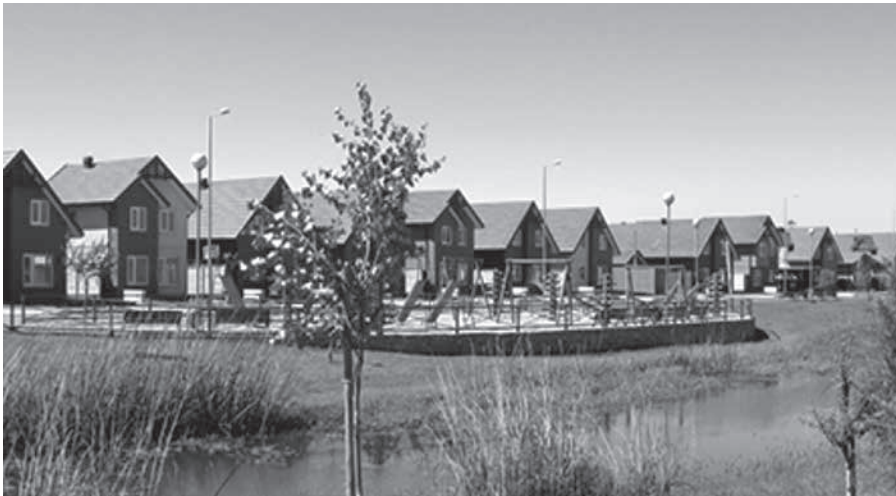
Figura 3. Viviendas Brisa del Sol (Revista Nos).
