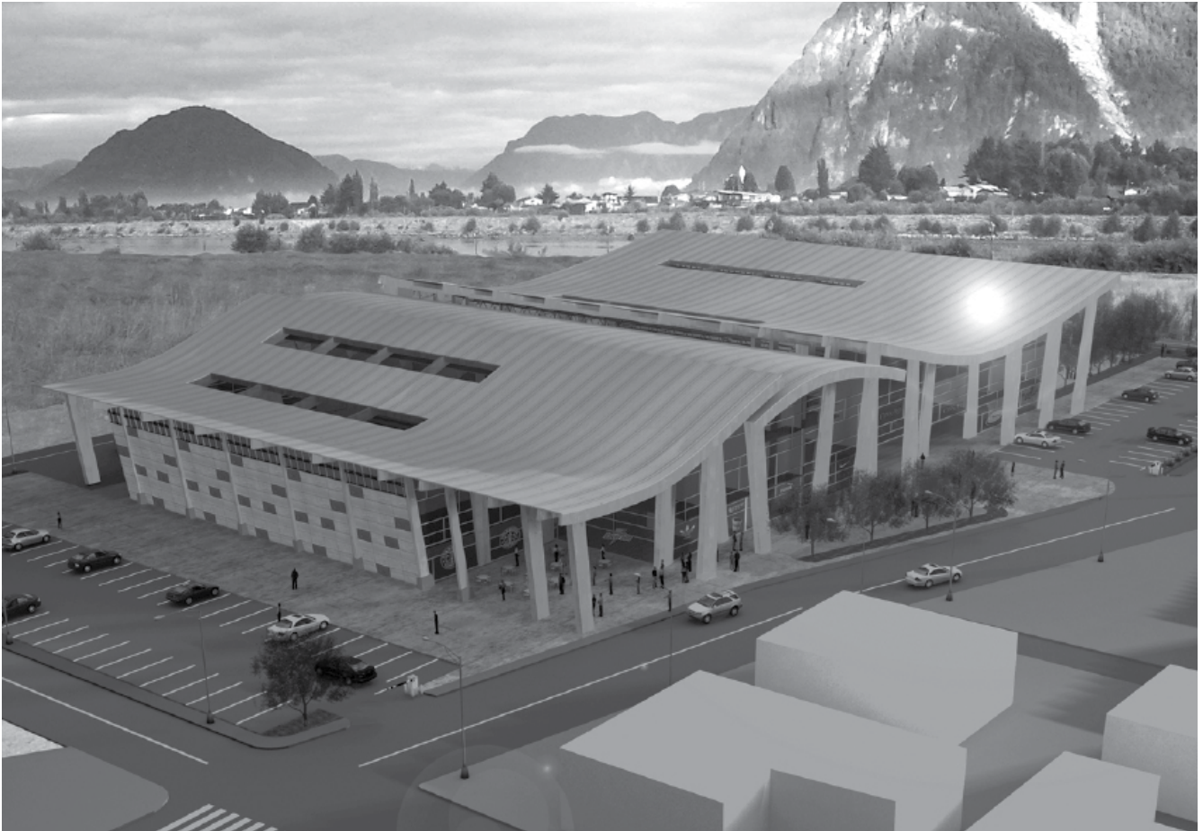
Emplazamiento y vista general del proyecto
