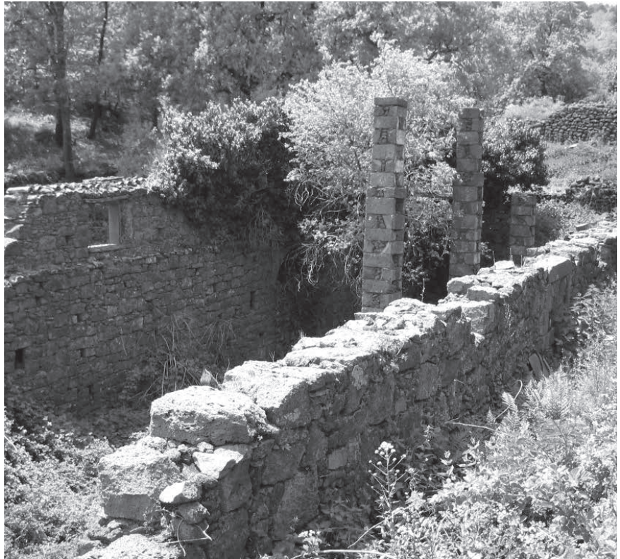
Fig. 2: Restos del edificio B. Bodegas
