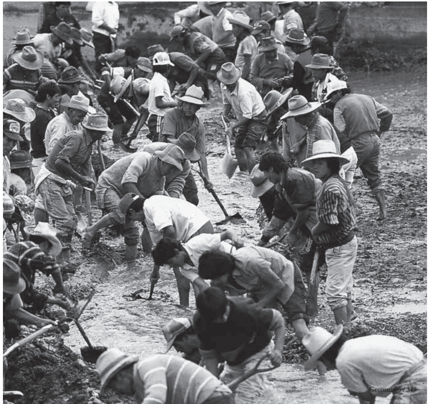
Fig. 1: Trabajo de limpieza de canales en Coporaque
