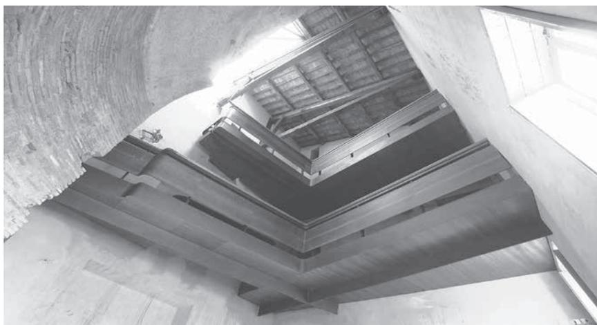
Foto 13, 14 y 15. Vista del puente-balcón apoyado en la estructura preexistente. Estructura de acero en cruz, tirantes y entrada de luz cenital.
