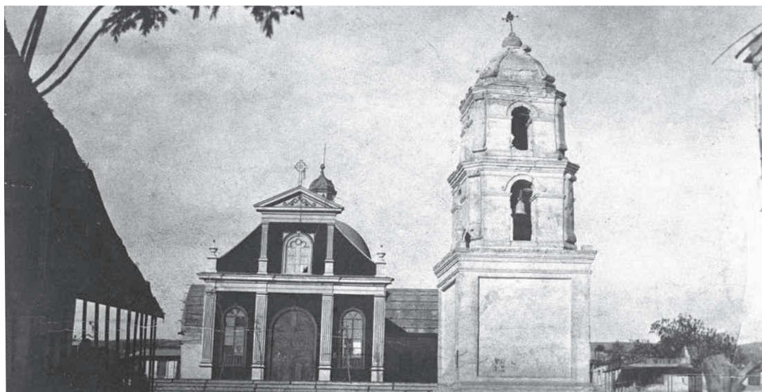
► Figura 6. Iglesia de Matilla, a inicios del siglo XX. Esta fotografía sirvió de referencia para los trabajos de restauración ejecutados en el campanil en los años 1950', que incluyeron reconstrucción de la cúpula. Fuente: Archivo Fotográfico Consejo de Monumentos Nacionales / Roberto Montandón Paillard.
