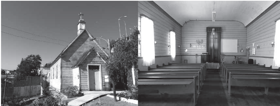
◀◀ (página anterior) Figura 1. Estado de deterioro. (Detalle). Fuente: Elaboración propia.
