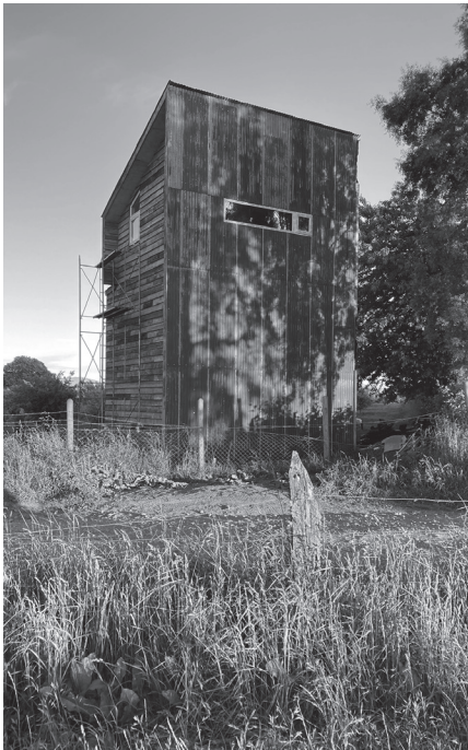
Figura 14. Vista norponiente. Fotografía, Rodrigo Aguilar.
