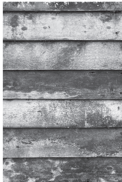
Figura 18. Detalle revestimiento exterior de madera recuperada. Fotografía, Rodrigo Aguilar P.
