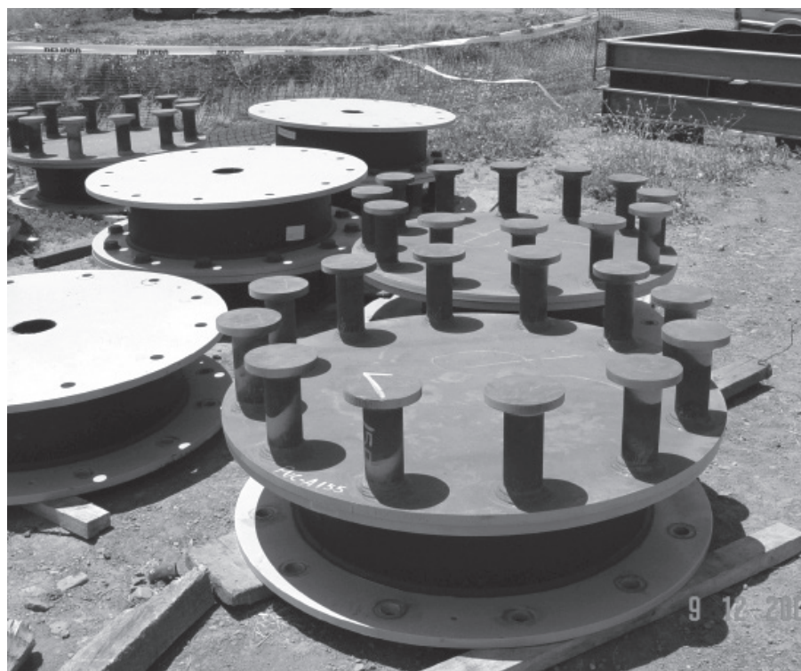
Figura 1. Hospital Militar. Aislador Basal. Fuente: Daniel Stagno.
