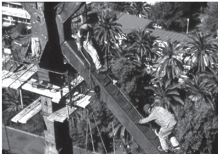
Figura 4. Edificio Telefónica. Fuente: René Lagos.
