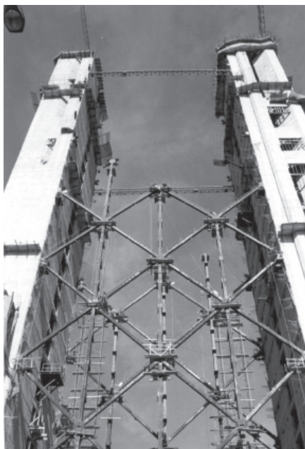
Figura 3. Edificio Telefónica. Fuente: René Lagos.
