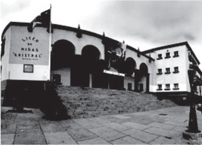
Vista fachada norte.
