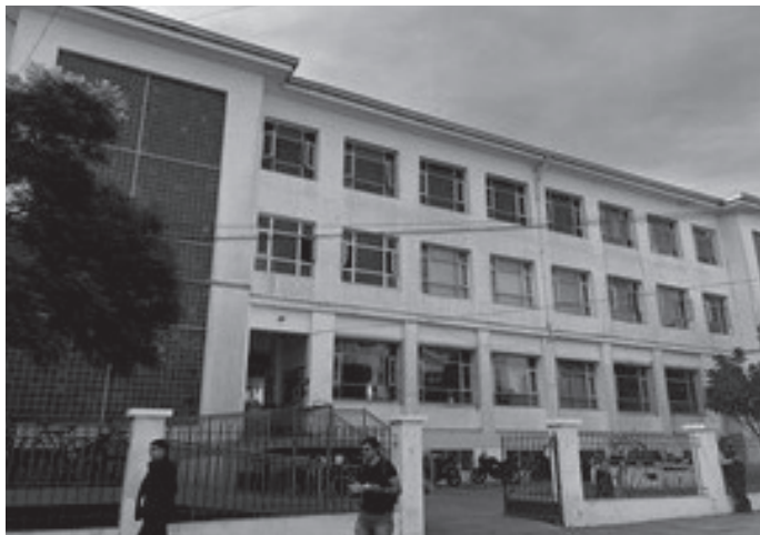
Vista fachada norte.
