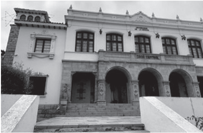
Vista fachada norte.
