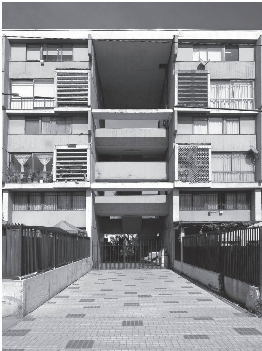
Figura 9. Vista acceso block 2. Unidad Vecinal Portales. Fuente: Archivo ao .
