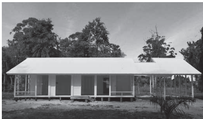
Figura 4. Fachada frontal. Fuente propia.
