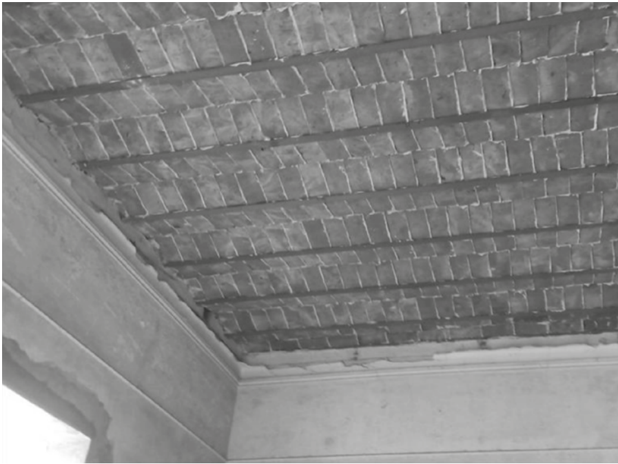
Figura 1. Bovedilla de perfiles y mampostería. Fuente propia.
