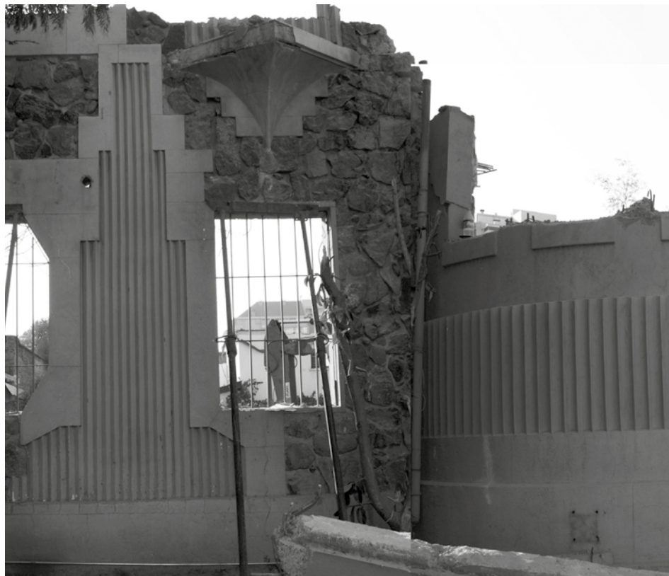
Demolición. Fuente propia.
