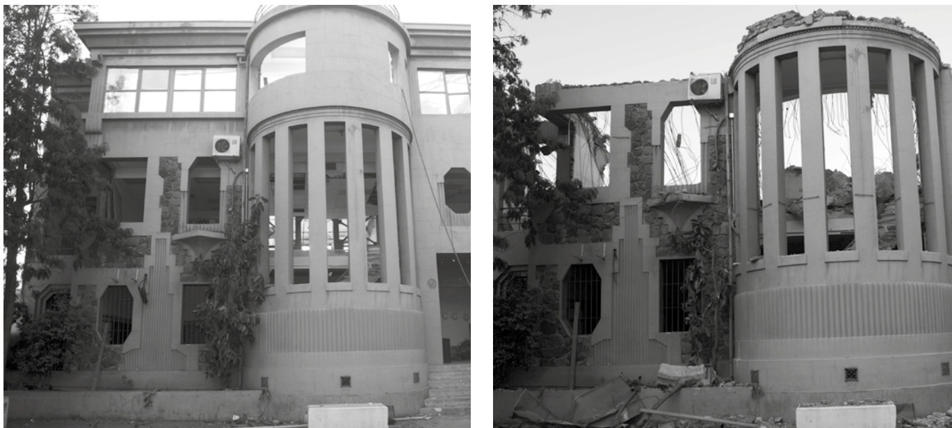
Figura 4. Fotografías del proceso de demolición de la casa. Corresponden a marzo de 2018. Fuente propia.
