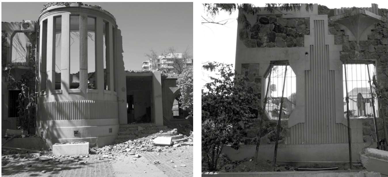
Figura 4a. Fotografías del proceso de demolición de la casa. Corresponden a abril de 2018. Fuente propia.
