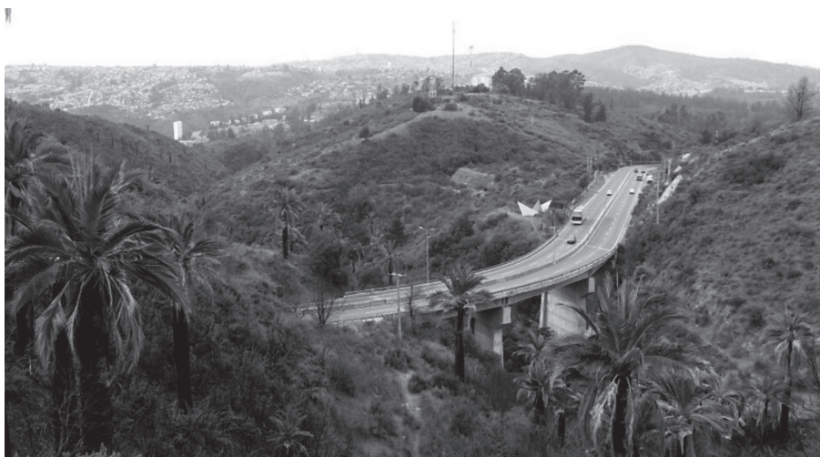
Figura 3. Trazado de autopista CH60 cuya construcción disectó el modelado del colinaje costero de Viña del Mar, provocando un gran impacto en el paisaje. Foto del autor.
