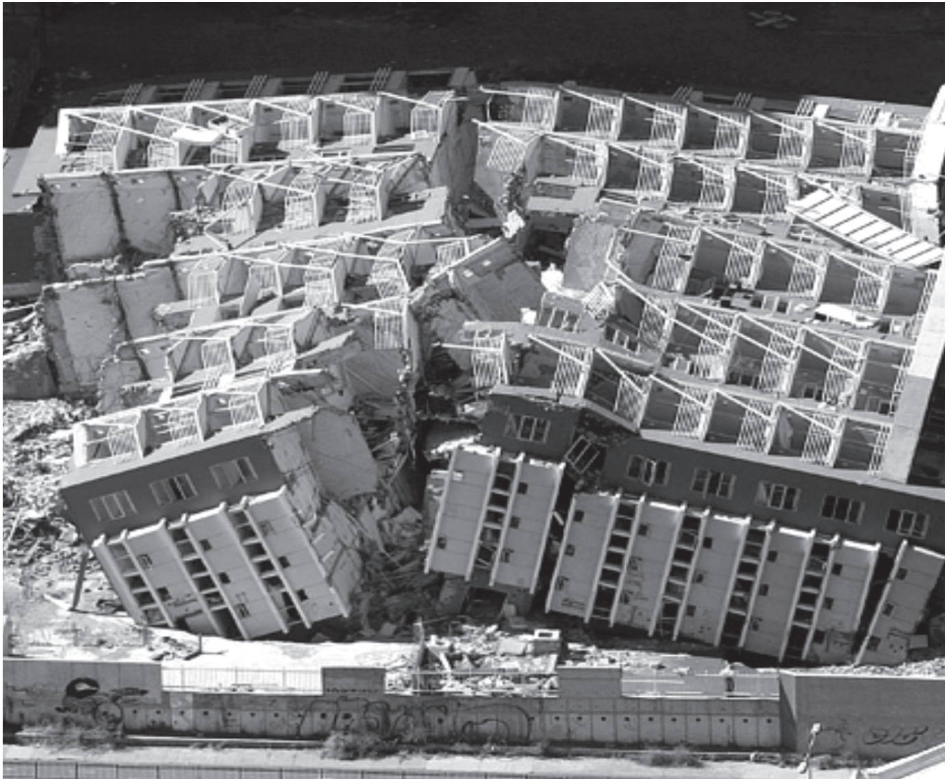
Figura 7. Vista aérea del edificio Alto Río (EMOL).
