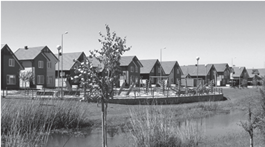
Figura 3. Viviendas Brisa del Sol (Revista Nos).
