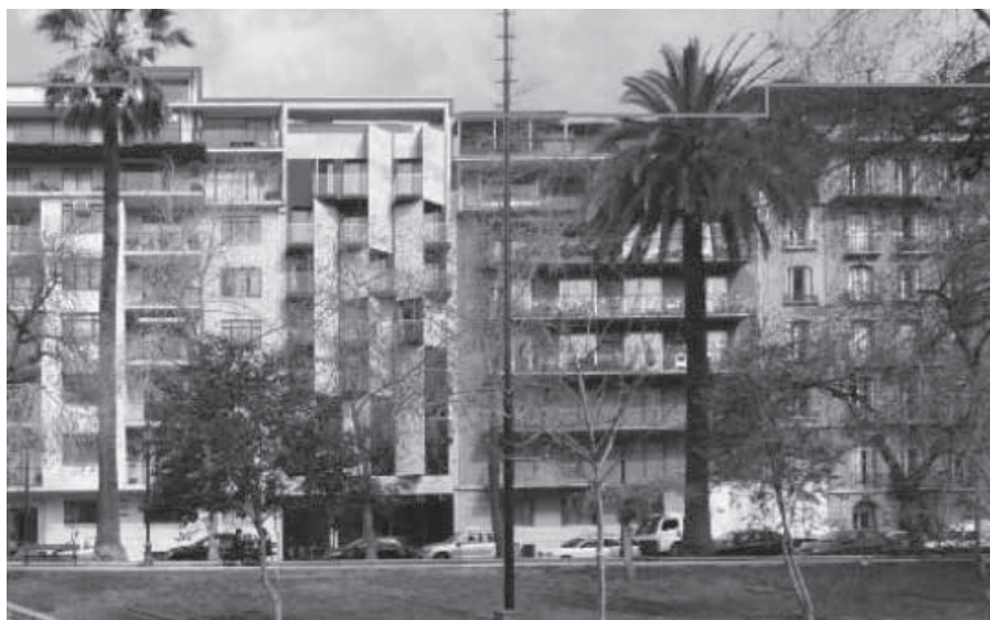
Figura 7. El proyecto Hotel Ismael 312, Estudio Larrain, rescata el patrón de las edificaciones contiguas generando una fachada análoga, creativa y continua, facilitando su inserción en el medio. Imagen intervenida. Fuente: Cristóbal Palma.
