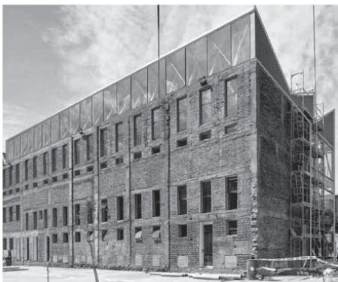
Figura 8. El Campus Creativo Universidad Andrés Bello, Schmidt Arquitectos, genera una ampliación superior contrastante recuperando el edificio con una cubierta de tipo industrial contemporánea coherente al uso anterior. Imagen intervenida. Fuente: www.campuscreativo.cl
