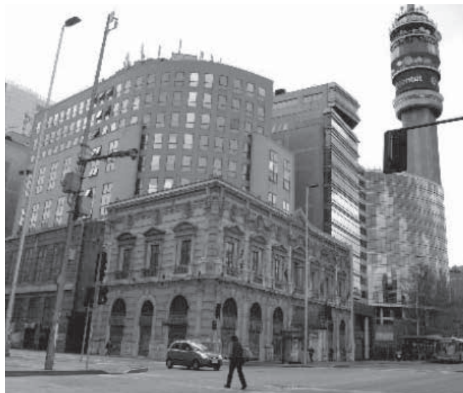
Figura 9. El Hotel Diego de Almagro genera una intervención de vaciado del inmueble desvirtuando su estructura así como su expresión externa. Fuente: Imagen intervenida por los autores.
